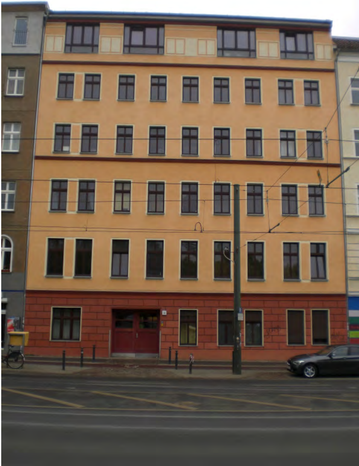
Auf diesem Bild sieht man, dieses Haus ist keine Ruine mehr. Man hat es mittlerweile saniert.
